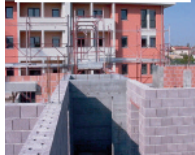
Palazzina a Ronchi dei Legionari (GO) Lecablocco Fonoisolante spessore 25 cm
