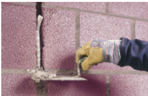
Corretto riempimento delle tracce impiantistiche.
