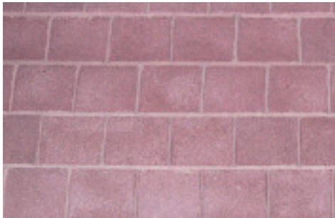
Corretta posa dei blocchi con malta nei giunti orizzontali e verticali.
