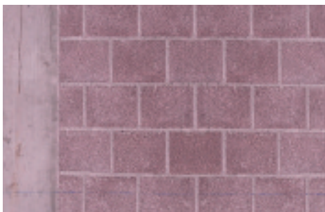
Giunto tra pilastro e muratura.
