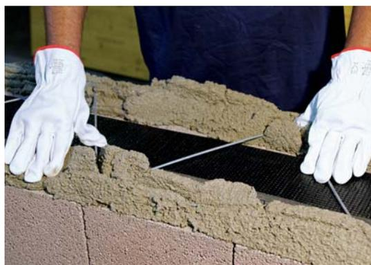
Posizionamento del traliccio metallico Murfor.
