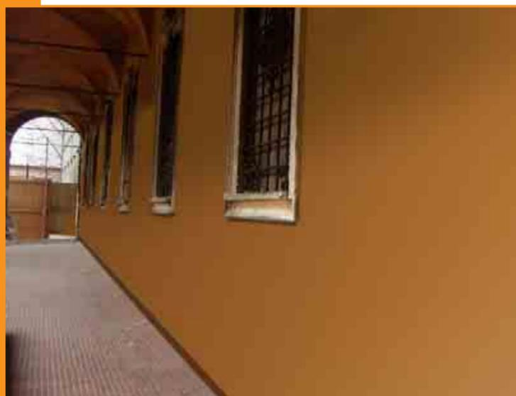
Ad avvenuta asciugatura, si procede al reintonaco utilizzando intonaco macroporoso traspirante MACROCOX previa stesura di impregnante antisalino WATERPROOF/S.
