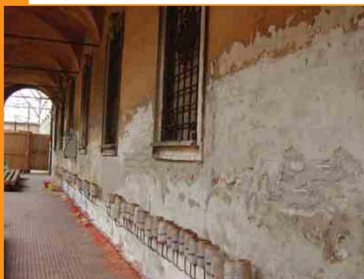
A seguito dell'intervento i muri devono essere stonacati sino all'altezza di 50 cm sopra il degrado esistente, per favorire l'evaporazione dell'umidità contenuta all'interno degli stessi.
