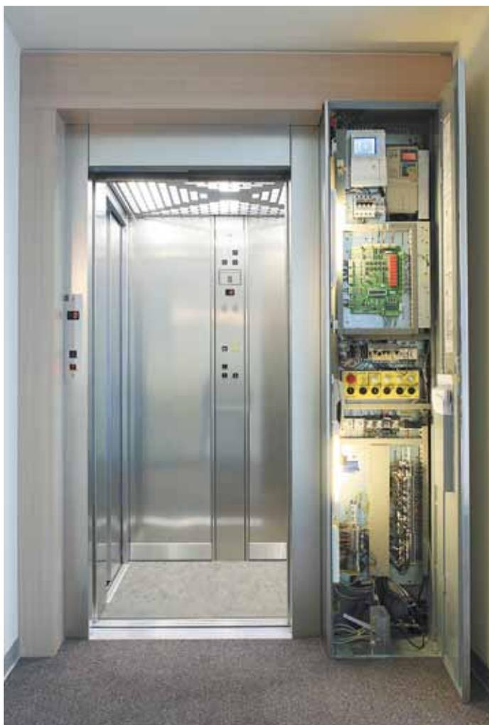
Installazione di un ascensore modello Overfit® - Gearless:
