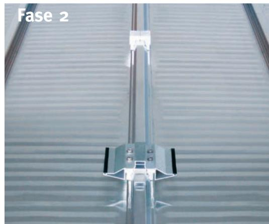
Posizionamento delle staffe Alluthin sulle Multiblock precedentemente fissate.
