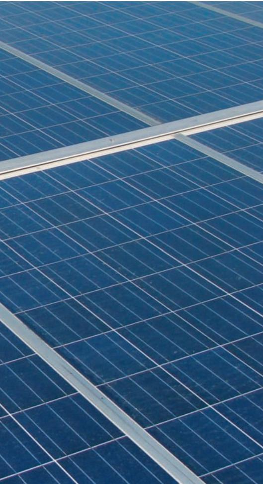
Profilo (cappellotto) in alluminio con guarnizioni per fissaggio moduli.
