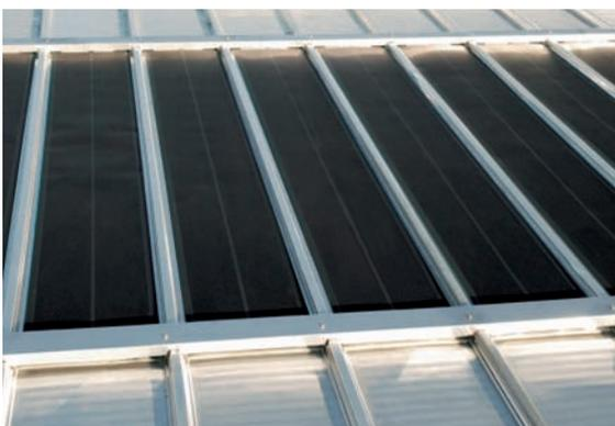
Moduli fotovoltaici in silicio amorfo che vengono applicati sulla lastra DRYTEC® sia retta che curva con inserimento a scatto. Le caratteristiche tecniche consentono i collegamenti elettrici in parallelo con una conseguente velocità di installazione.
