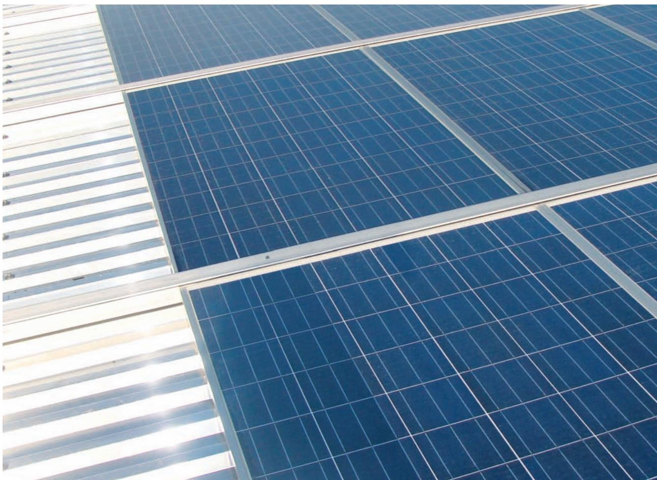
Il profilo in alluminio estruso è fornito in lunghezza variabile a seconda della lunghezza di falda; è composto da un elemento inferiore di supporto e da un cappello superiore di chiusura per il fissaggio dei moduli fotovoltaici.
