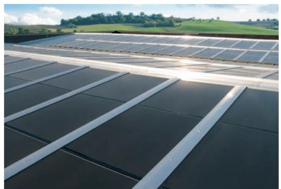
Moduli fotovoltaici in film sottile (silicio amorfo) ora anche **Tandem** microcristallino prodotti da Nex Power. Il film sottile, a differenza dei moduli in silicio cristallino, produce energia anche in condizioni di luce diffusa, questa caratteristica li rende particolarmente indicati per l'applicazione su tetti piani e su falde con esposizione non ottimale.
