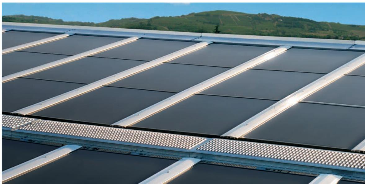
Il fotovoltaico film sottile amorfo ed ora anche **Tandem** è indicato per le coperture industriali che spesso presentano inclinazioni di falda e orientamento non ottimali. CentroMetal con il partner Nex Power garantisce così un impianto in continua produzione energetica.
