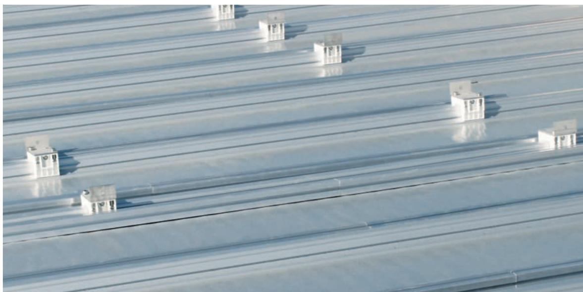
Questa è la soluzione ideale per l'applicazione di qualsiasi modulo fotovoltaico sulla copertura DRYTEC®. L'innovativa staffa Multiblock permette l'installazione di strutture di sostegno per moduli fotovoltaici senza fori in copertura.
