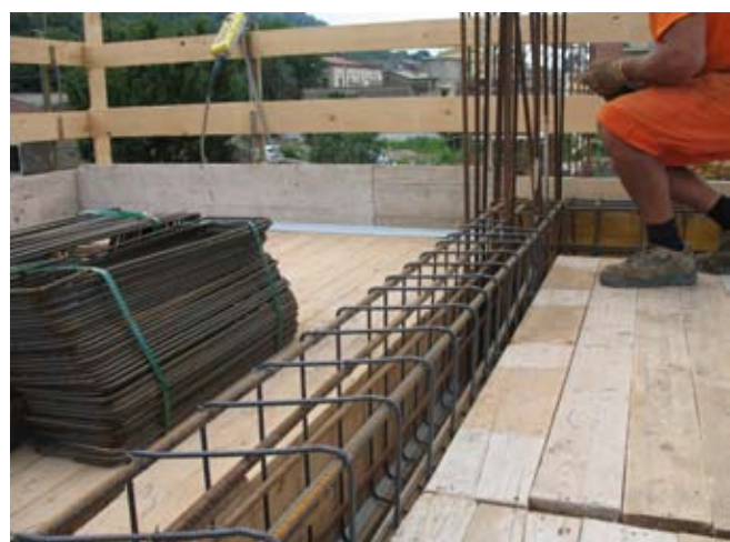
Trave emergente / Flat beam / Poutre émergente
