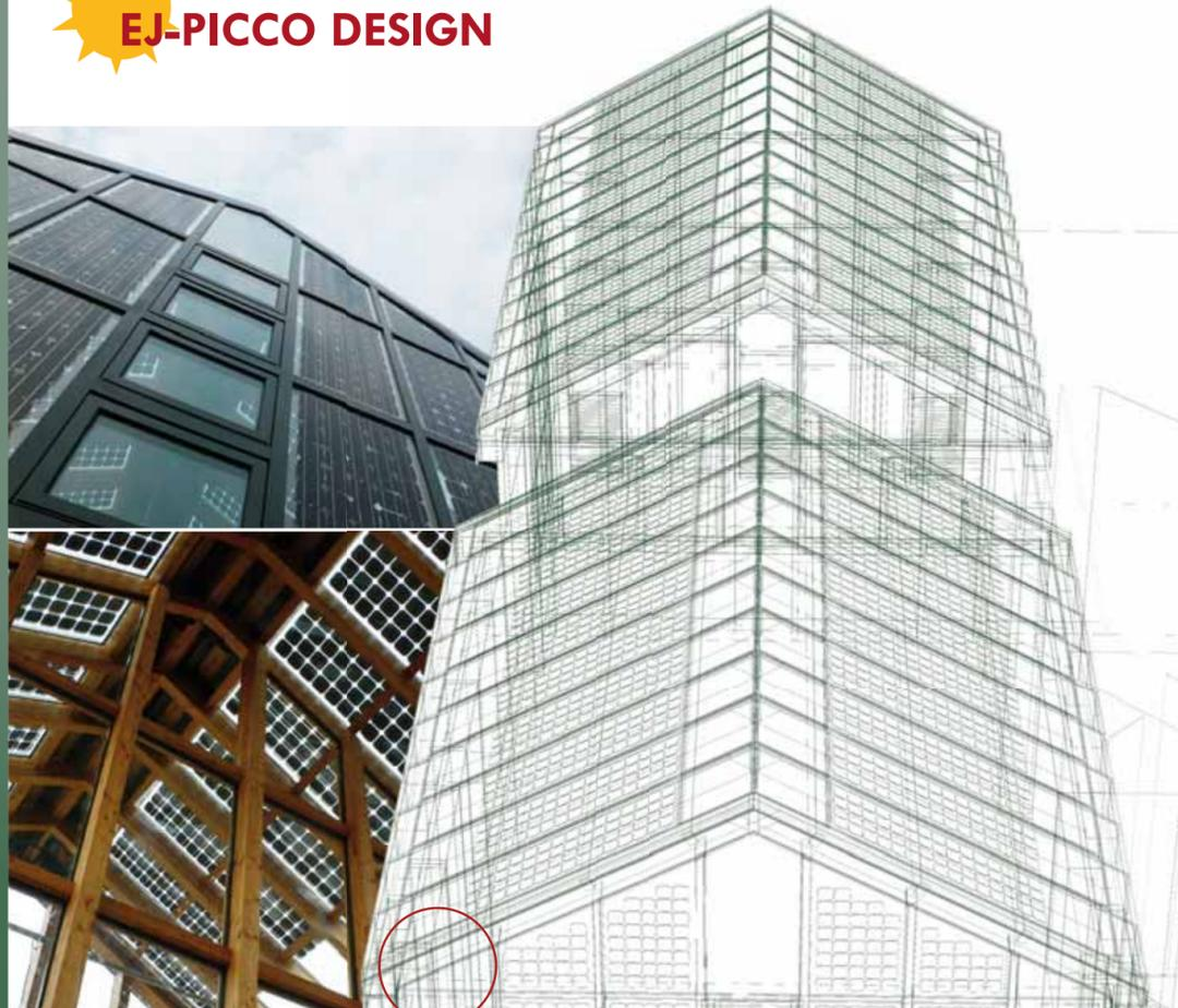
Realizzazione di museo con struttura in legno lamellare e pannelli fotovoltaici
