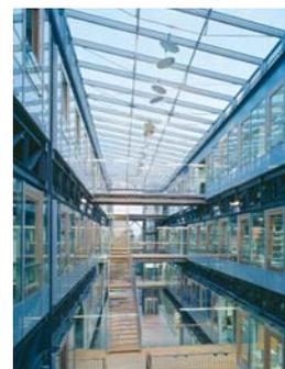
Nelle facciate verticali la ventilazione e lo scarico dell'acqua dalla scanalatura del vetro avviene a zone, mentre nelle vetrate inclinate e nelle coperture essi sono assicurati ai punti d'estremità dei montanti. Per motivi di stabilità globale consigliamo, per la realizzazione di questi elementi, la saldatura, in quanto permette di prefabbricare in gran parte la costruzione in officina.
