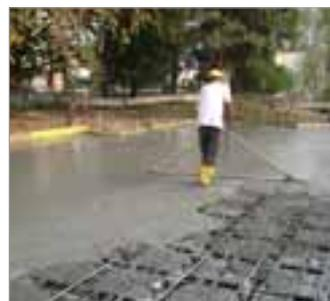
Particolari fotografici della sequenza completa di posa in opera: realizzazione dell'impalcato, posa di U-Boot Beton<sup>®</sup> e dell'armatura della struttura, getto e lisciatura finale.
