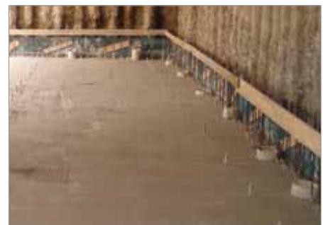
Particolari fotografici della sequenza completa di posa in opera: realizzazione dell'impalcato, posa di U-Bahn Beton<sup>®</sup> e dell'armatura della struttura, getto e lisciatura finale.
