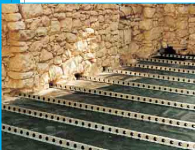
È un sistema di consolidamento che evita la demolizione del solaio, conservandolo nel tempo e garantendogli le migliori condizioni in termini estetici e di solidità e deformazioni pari a 1/500 della luce.
