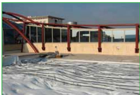
Cuore del sistema è la perlite espansa **Igroperlite®**, contenuta in materassini di speciale geotessuto che, oltre alle sue peculiari funzioni di **accumulo idrico**, di **drenaggio** e **termoregolazione**, svolge nei parcheggi ecologici altri importantissimi compiti:
