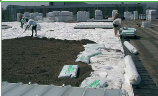
▶ Posa di substrato culturale AgriTERRAM® su sacchi di Igroperlite® su copertura piana
