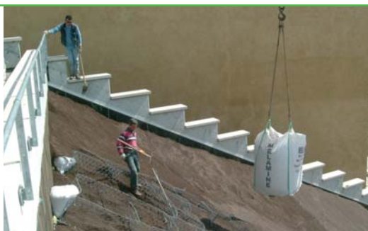
▼ Posa di substrato culturale AgriTERRAM® su sacchi di Igroperlite® su copertura inclinata
