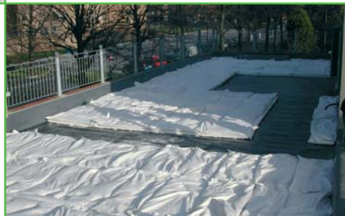
▼ Esempio di stratigrafia: membrana antiradice – lastre Supergarden – sacchetti Igropelite®
