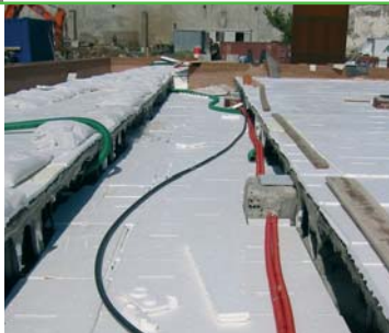
▼ Rete primaria di impianto di irrigazione su elementi di drenaggio Supergarden
