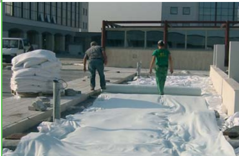
▼ Stesura dell'elemento filtrante DRENALIT® F
