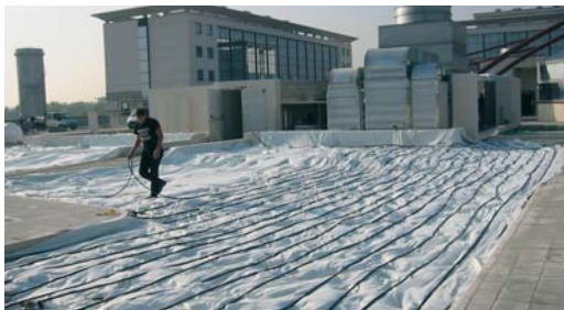
▼ Stesura delle tubazioni di impianto di subirrigazione sopra ai sacchi di Igroperlite®
