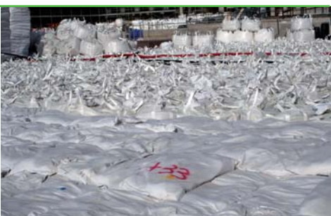
▼ Stesura di sacchi e sacconi di Igroperlite® in multistrato per stratigrafie di spessore elevato
