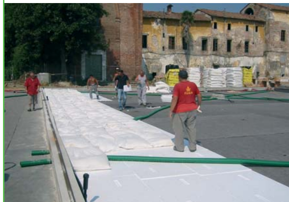
▼ Particolare di tubi di drenaggio integrati con lastre Supergarden
