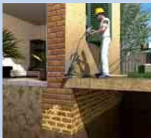
**Iniezioni di consolidamento in murature ammalorate**
