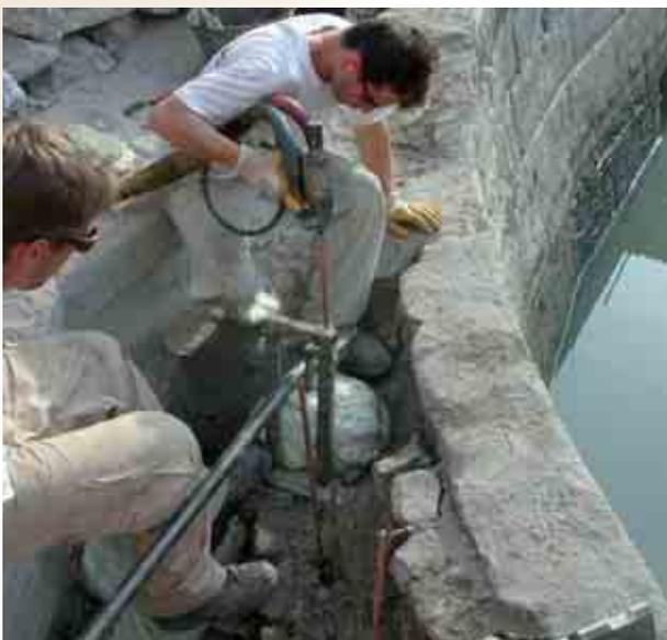
Il metodo Uretek Walls Restoring® è in grado di aumentare la resistenza meccanica di un sistema murario, di diminuirne la permeabilità e può essere eseguito anche in presenza d'acqua.
