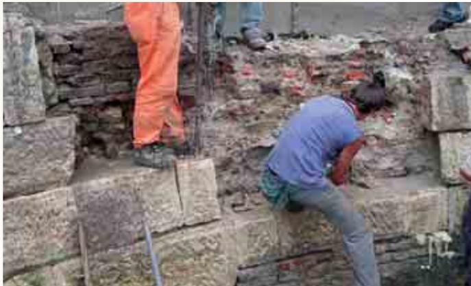
sperimentale, al termine delle iniezioni, si è proceduto allo smontaggio del segmento di paramento iniettato. Le fotografie illustrano le varie fasi di scavo, demolizione e trasporto sulla chiatta del campione prelevato.
