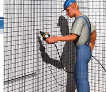
Tracce di servizio vengono create con lo scioglimento del polistirene dietro la maglia metallica tramite l'uso di una pistola ad aria calda o di una qualsiasi fonte di calore.
