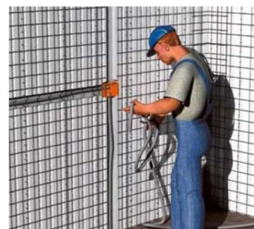
La spruzzatura dello strato di rivestimento sul pannello utilizzando l'intonacatrice.
