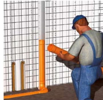
Il posizionamento delle tubature per i servizi (elettricità, acqua, gas, ecc.), viene eseguito in modo semplice e rapido, dietro la maglia metallica.
