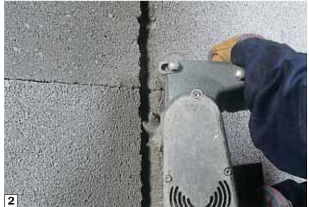
**2.** Tracciatura degli impianti mediante scanalatore a fresa.
