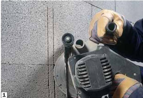
**1.** Tracciatura degli impianti mediante scanalatore a dischi.
