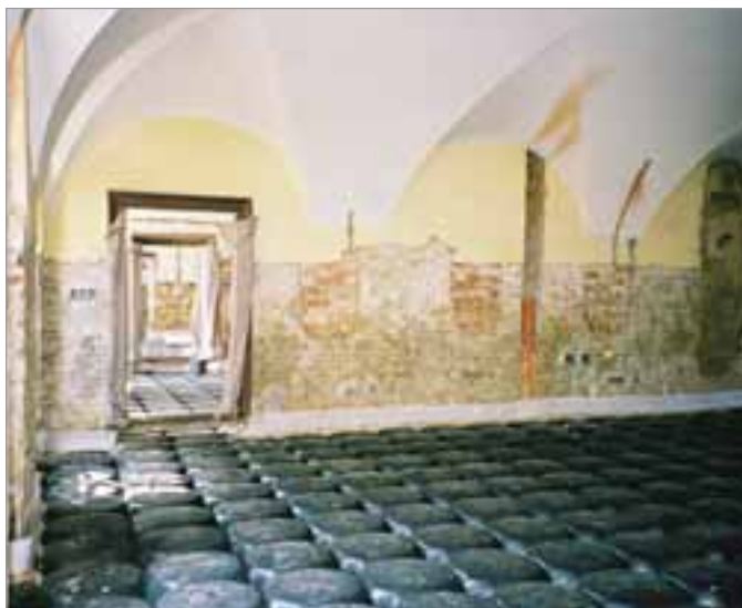
Restauro edificio storico
