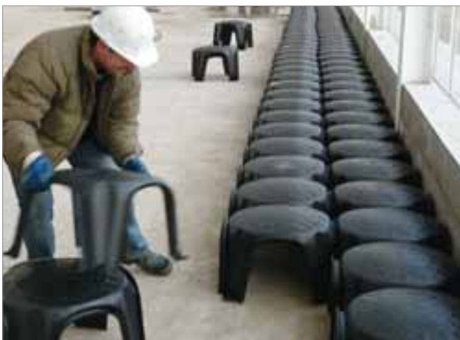
Fig. 3 - Particolare della fase di innesto del sistema maschio-femmina - Da notare la perfetta sigillatura del piede.
