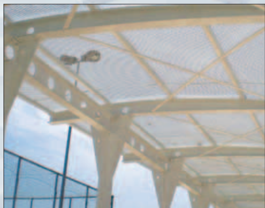
PS 01 - DL 53,5 x DC 20 (21,5) - av 4,8 x sp 2 mm Ferro zincato a caldo, verniciato con polvere poliestere per esterno
