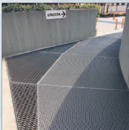
FILS 6 - DL 90 x DC 30 (22,3) - av 7,5 x sp 4 mm FILS 20 - DL 45 x DC 15 (11,4) - av 3,3 x sp 3 mm Ferro zincato a caldo
