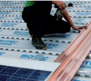
Posa della prima scossalina laterale
