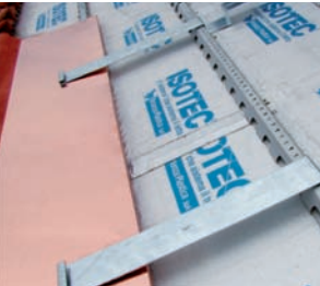
Posa e fissaggio della prima coppia di staffe
