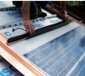
Chiusura a monte con profilo dotato di pettine parapasseri
