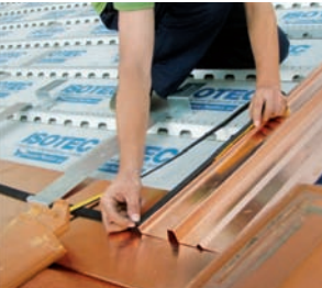
Posa delle guarnizioni per l'appoggio dei moduli sulle scossaline
