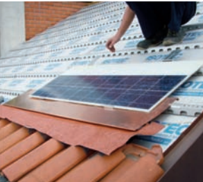
Posa del primo modulo
