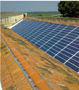
Andria (BA) – Antica masseria. Potenza impianto: 30 kWp.
