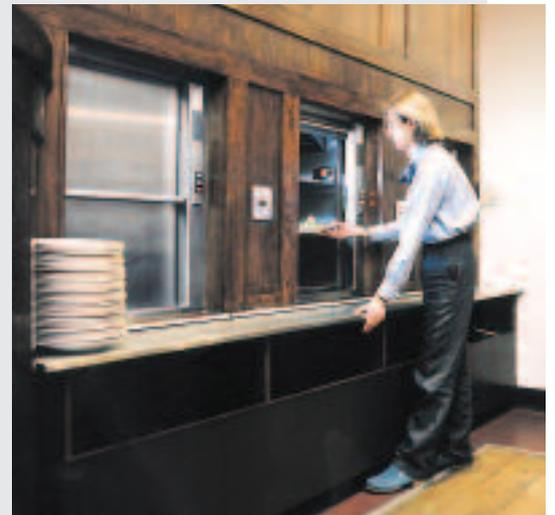
La sua struttura modulare portante ne agevola l'installazione in ogni tipo di ambiente. È sufficiente un foro di passaggio in ogni singola soletta, una chiusura del vano con materiali adatti all'ambiente circostante ed una linea elettrica dedicata per poter disporre del **Microlift** in pochissimo tempo, sia in edifici nuovi che esistenti.
