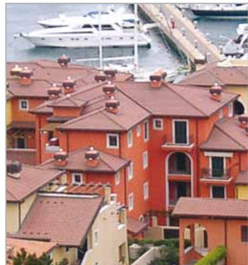
Uno degli edifici di Borgo Porto San Rocco con copertura formata da 25 falde per un totale di circa 500 mq. Nonostante la complessità della copertura lo scarto è stato contenuto entro il 3%.
