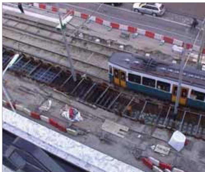
Restauro banchina della metropolitana
