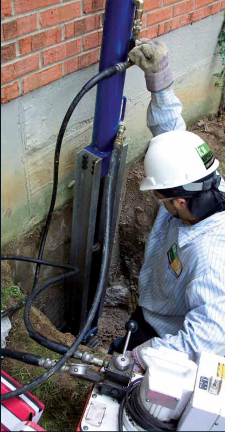
Entrambi sono ***immediatamente attivi***, in virtù del precarico effettuato su ogni singolo palo prima del collegamento finale alla struttura.
