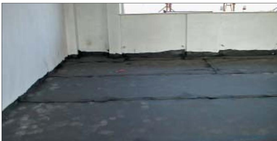
Particolare della posa di **guttasilent® N** con saldatura ad aria calda delle sovrapposizioni.
