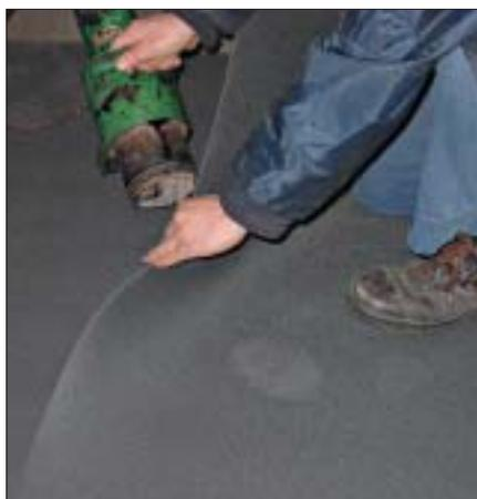
Saldatura a caldo dei due lembi di giunzione.
