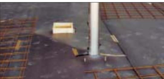
Particolare di posa di **guttasilent® N** in presenza di pilastri circolari.
