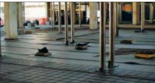
Desolarizzazione dei pavimenti con posa di **guttasilent® N** saldato con aria calda.
