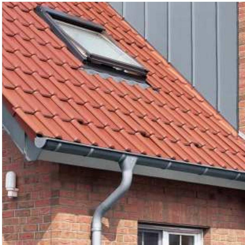
Bocchetta d'aggancio per canale semitondo, saldatura a macchina, di forma diritta (per plu- viale e tubo inclinato conico)
