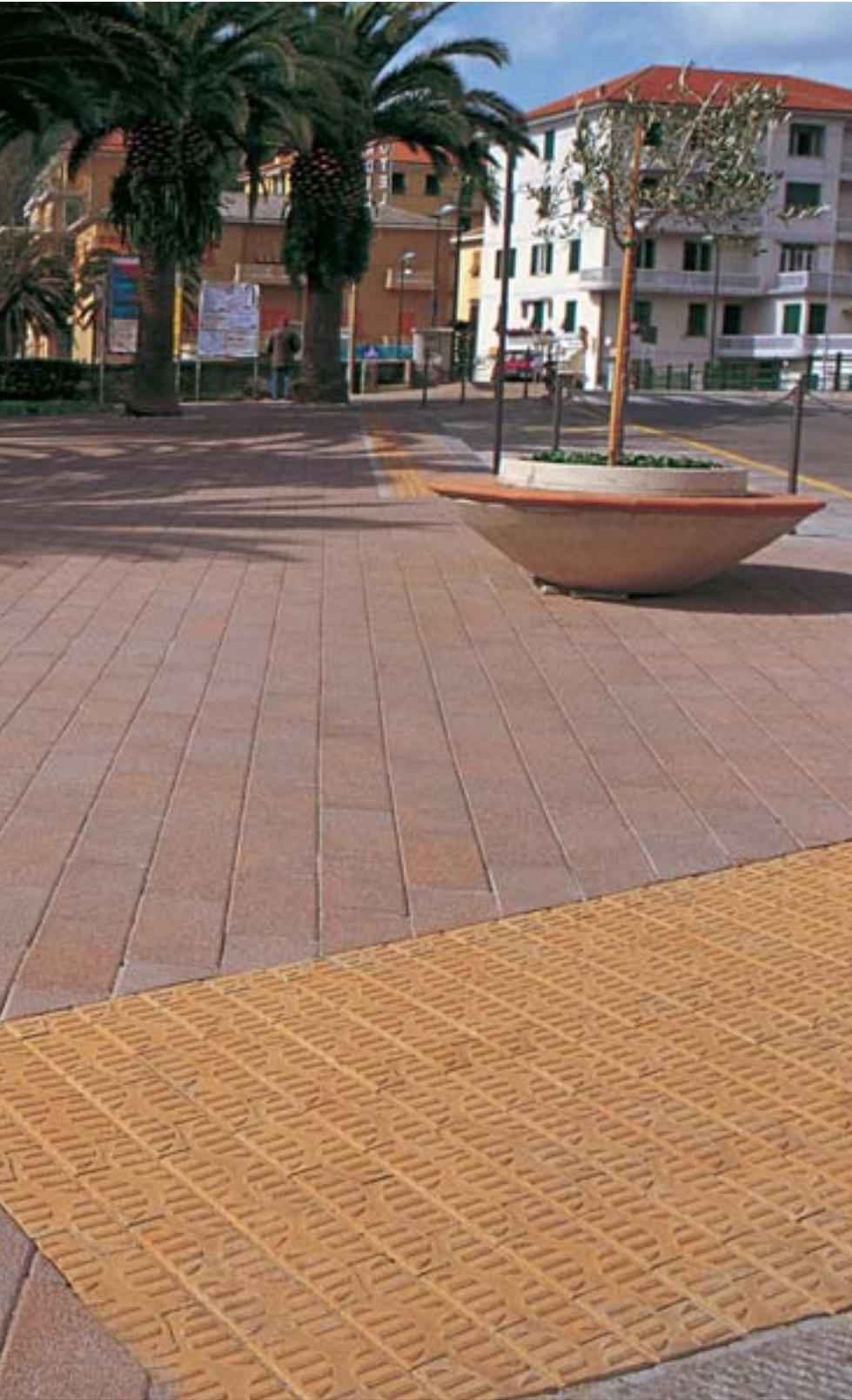
Il Sistema Arianna consiste di 3 modelli di pavimentazione per l'abbattimento delle barriere architettoniche: CIOTOLO, RIGO e TRATTO.
