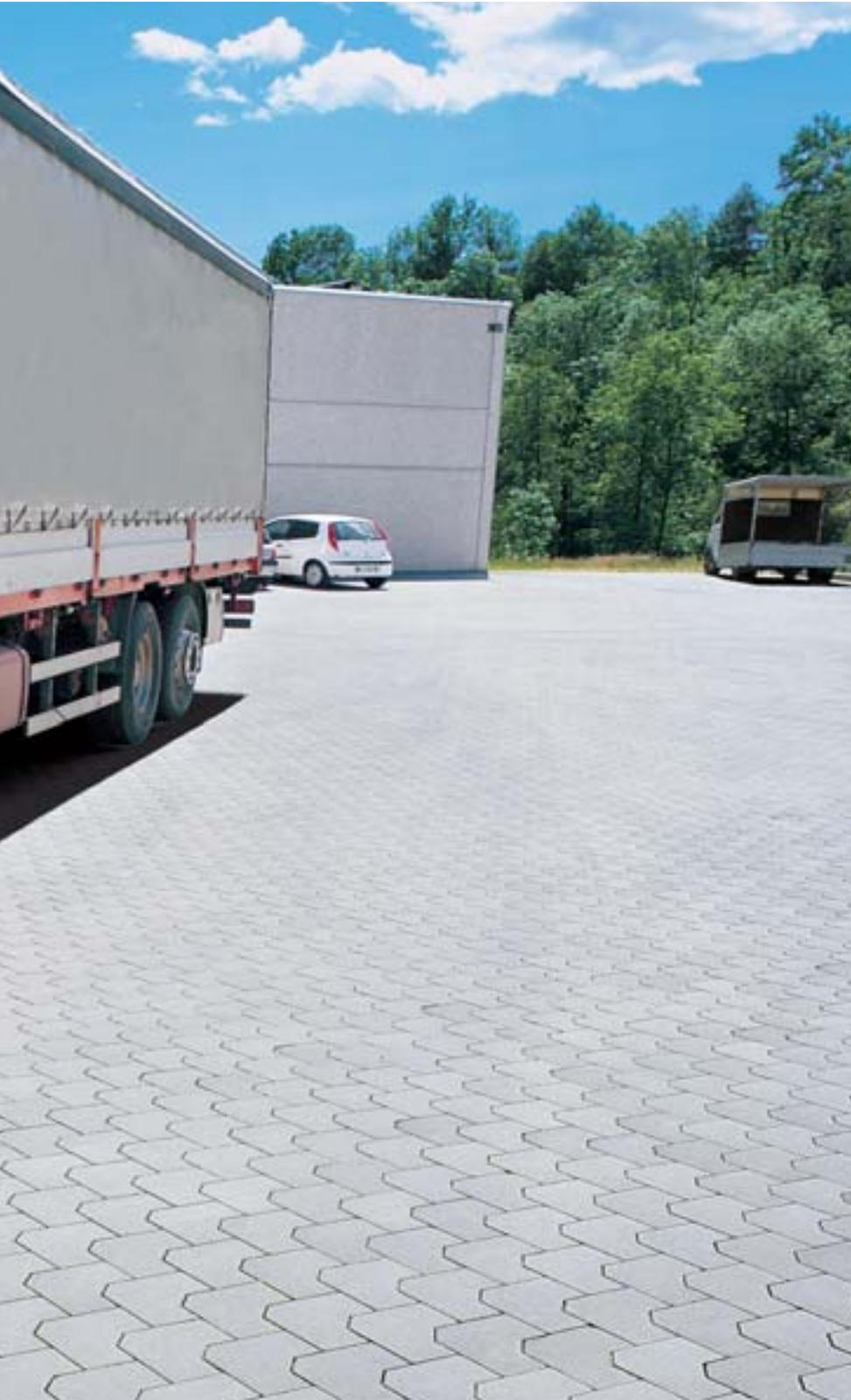
Il massimo grado di autobloccanza e di solidità ottenibile in un formato di massetto. SIDNEY rappresenta una rivisitazione perfezionata della pavimentazione a mattoni posata a "spina di pesce". Riproduce lo stesso schema, con il vantaggio che i "mattoni" sono fra loro collegati a due a due, con un'insuperabile capacità di opporsi alle sollecitazioni e di trasmettere quindi i carichi ai masselli adiacenti. SIDNEY rappresenta la risposta più efficace ad ogni tipo di sollecitazione da traffico.
