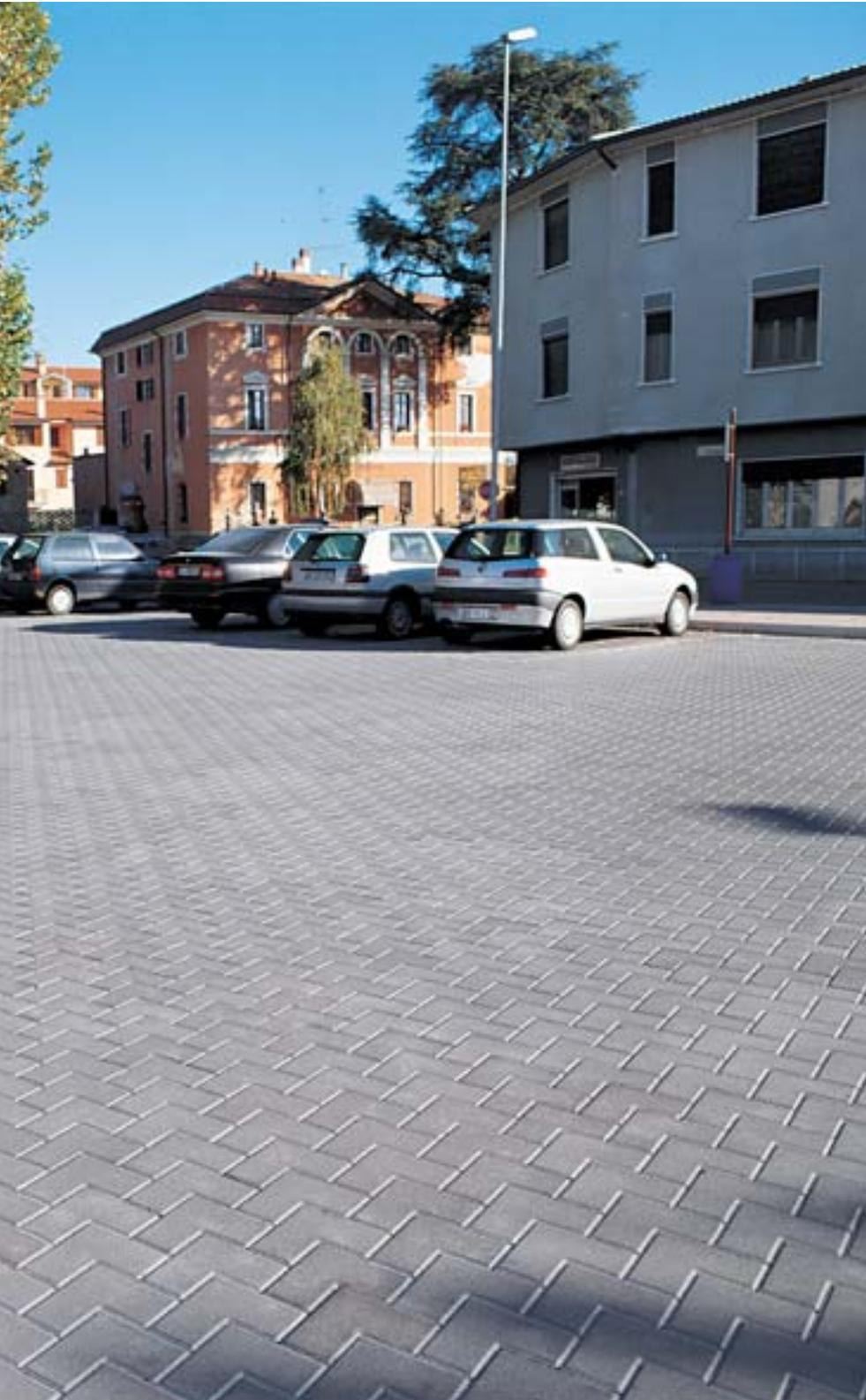
La forma di ELLE consente di ottenere il massimo grado di autobloccanza realizzabile con un massetto. ELLE rappresenta una rivisitazione perfezionata della pavimentazione a mattoni posata a "spina di pesce". Riproduce lo stesso schema, con il vantaggio che i "mattoni" sono fra loro collegati a due a due, con un'insuperabile capacità di opporsi alle sollecitazioni e di trasmettere quindi i carichi ai masselli adiacenti. La risposta più efficace ad ogni tipo di sollecitazione da traffico.
