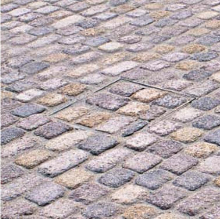
Chiusini zincati da riempire in opera con il massetto, per uniformare il manufatto al resto della pavimentazione ed ottenere un pregevole effetto estetico.
