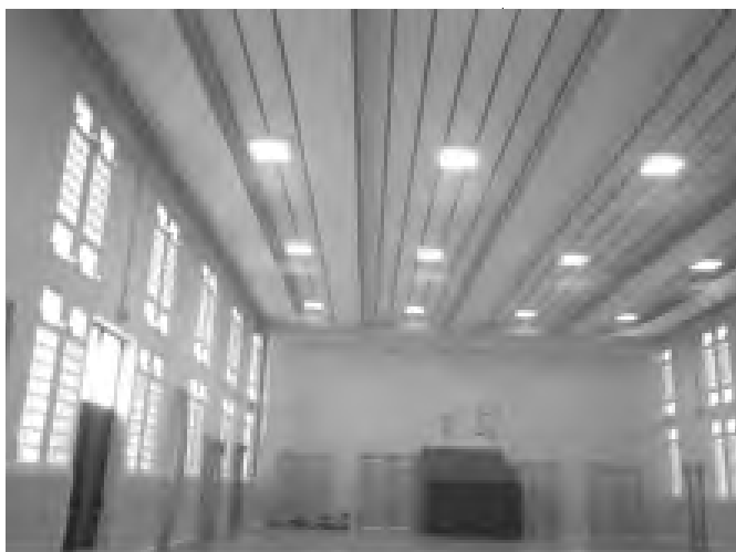
Fig. 1 - Sistemi radianti parzialmente spenti.
